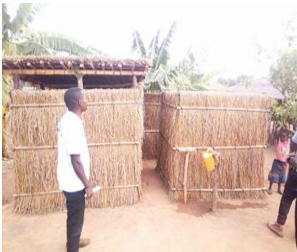
Figura 9: Latrinas tradicionais melhoradas com sistema de lavagem das mãos
